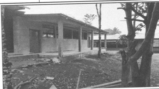
Foto 2: Se Observa en el lado de enfrente de la cocina.
